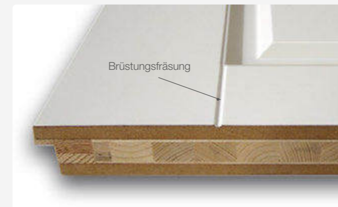
Querschnitt: 3-schichtiger Türblattaufbau
