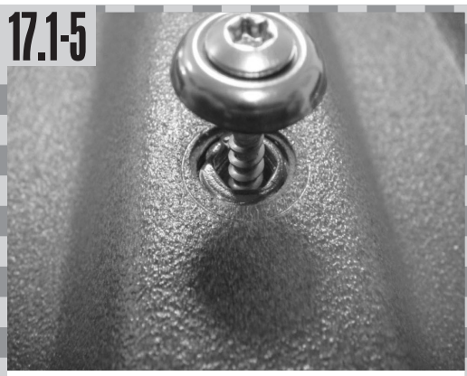
17.1-5 Spenglerschraube setzen...
