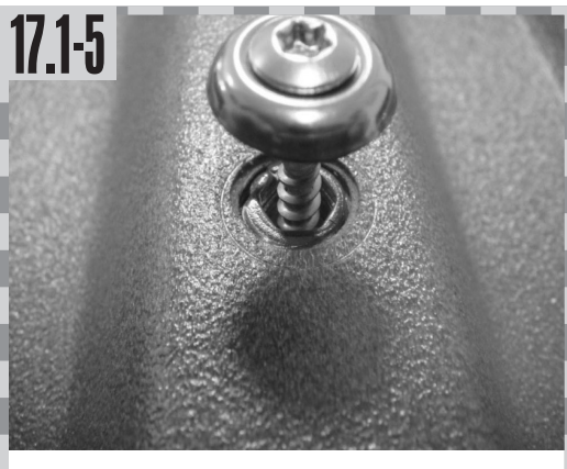
17.1-5 Spenglerschraube setzen...
