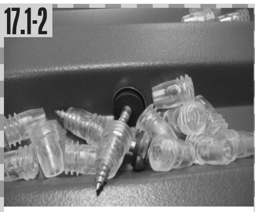
17.1-2 Abstandshalter und Schrauben auf der Bedachungsplatte ablegen
