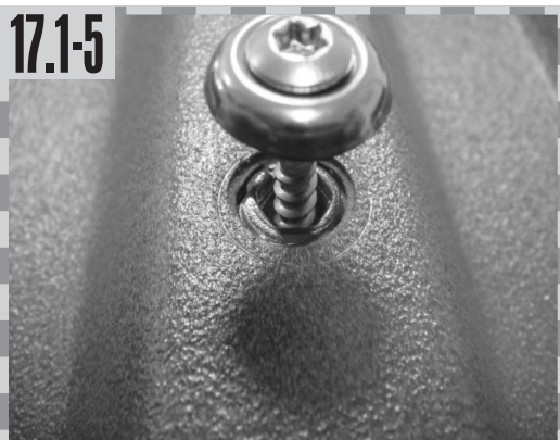
17.1-5 Spenglerschraube setzen...
