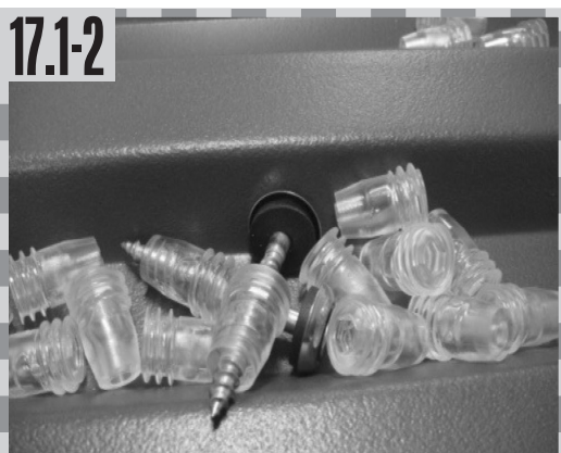
17.1-2 Abstandshalter und Schrauben auf der Bedachungsplatte ablegen
