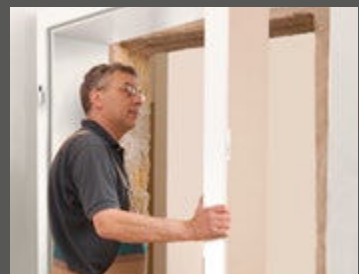
Ab Werk montierte Zargen erleichtern den Einbau vor Ort
