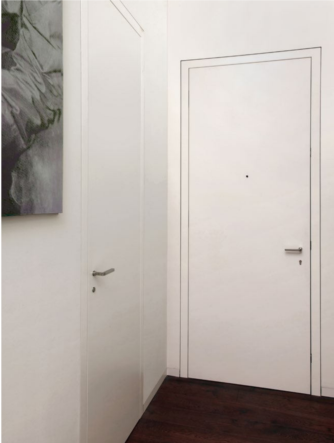
Türblatt 62 mm, Typ G | Ausführung stumpf, 3 verdeckte Bänder | Schleiflack weiß RAL 9016 Zarge K50 mit vorab gesetzter Putzzarge und 5 mm Schattenfuge
