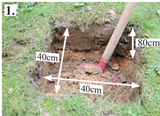
Eine Grube für jeden Pfosten ausheben.
